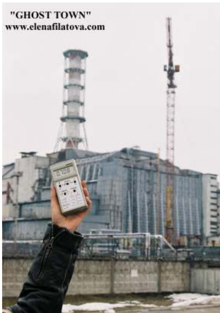
Tsjernobyl reaktoren 2008: Arbeidene med å støpe et tykk betongskall som skal innkapsle radioaktiviteten er veldig tids- og ressurskrevende; arbeiderne kan bare oppholde seg ved reaktoren i veldig korte tidsintervaller.
